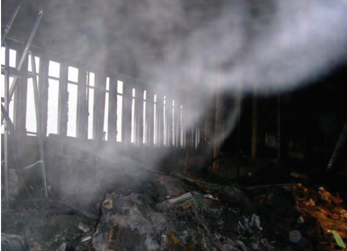
Le plus important incendie enregistré jusqu'à fin octobre 2007 a ravagé une usine de La Chaux-de-Fonds; il est dû à la défectuosité d'appareils électriques.
